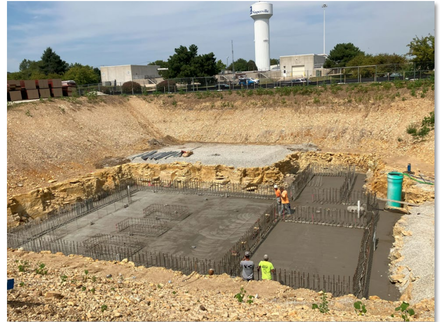
South Plant grit/RAS base slab pour
